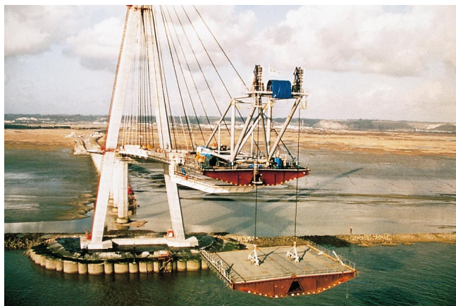
Figure 49 – Montage par encorbellement du pont de Normandie (doc. SETRA/G. Forquet)
