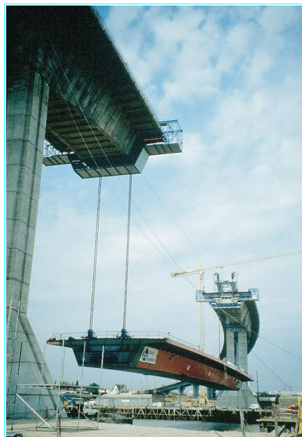
Figure 51 – Hissage de la travée principale du pont de Cheviré à Nantes (doc. OTUA)
