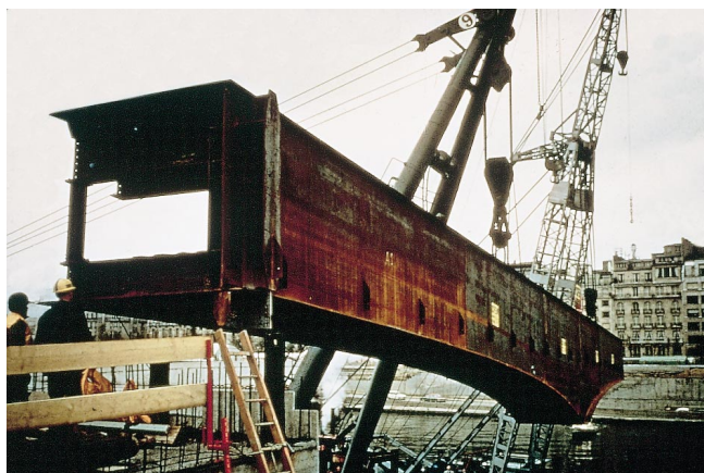
Figure 48 – Levage à la bigue flottante (doc. CFEM)
